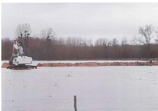
Pelleteuse à chenilles supprimant le samedi 27 janvier 2018 un merlon de protection du plan d'eau à Pont-Seine, alors que la crue maximale est annoncée le lendemain.
