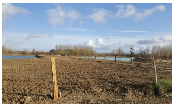
Exemple de réaménagement coordonné après la suppression des merlons de protection du bassin de décantation et la mise en place d'une clôture 3 fils à La Villeneuve-au-Châtelot.
